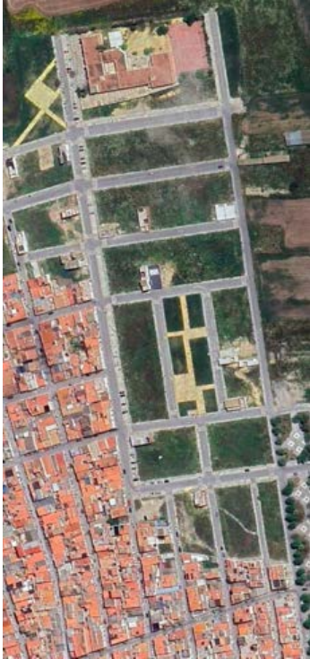
Ejecución SUP-6 a fecha 19/04/2024. Se encuentran edificadas o en construcción alrededor de treinta de ellas.
