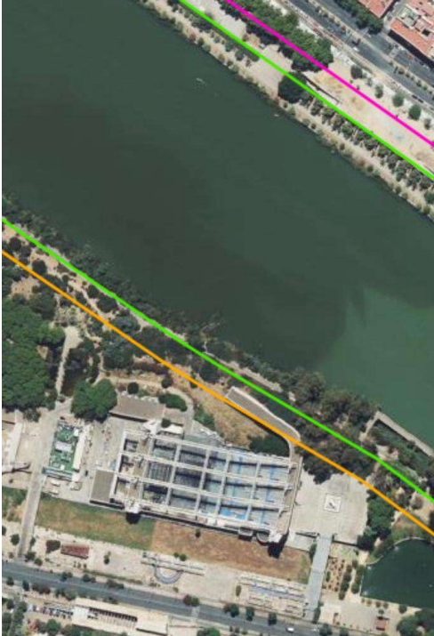
Foto 4) Imagen del edificio y su afécción a las líneas de Dominio Público Marítimo Terrestre y de servidumbre
